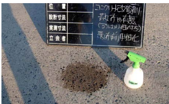
写真⑤ 施工前：表面中性化確認
