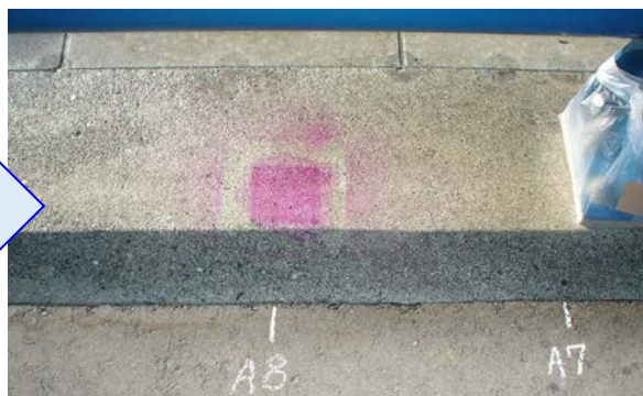
写真② CS-21塗布後
