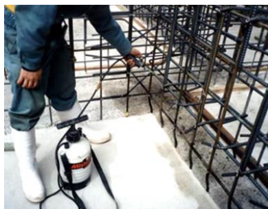
写真2 水平打継ぎ部処理
