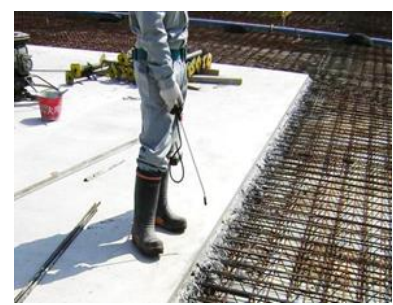
写真3 鉛直打継ぎ部処理
