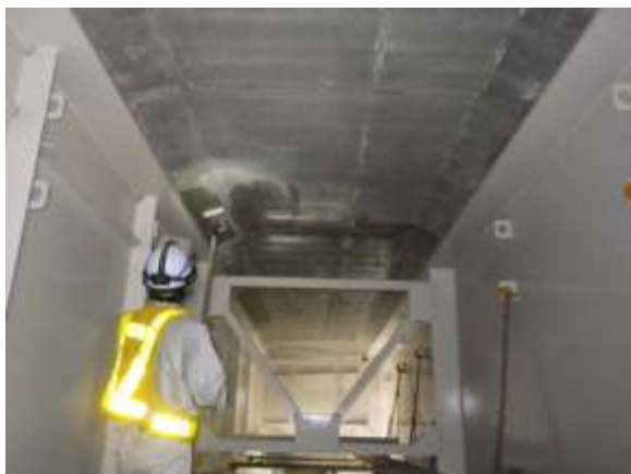
床版下面：CS-21ネオ塗布状況
