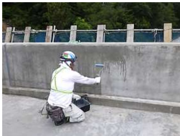
壁高欄：CS-21ネオ塗布状況
