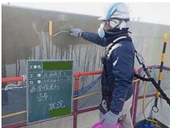
壁高欄：CS-21ネオ塗布状況
