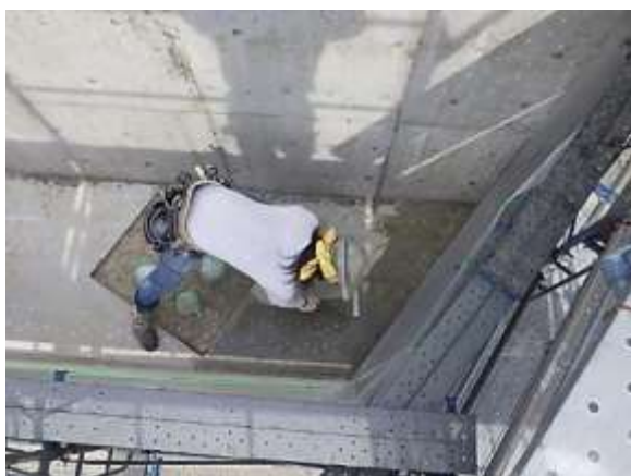
橋座部：CS-21ネオ塗布状況
