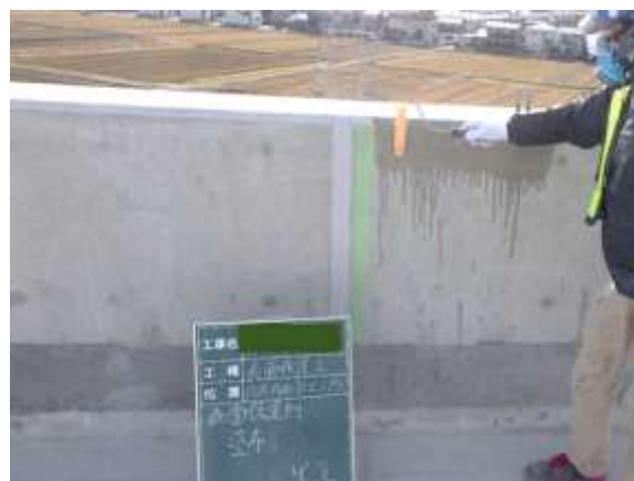
壁高欄：CS-21ネオ塗布状況
