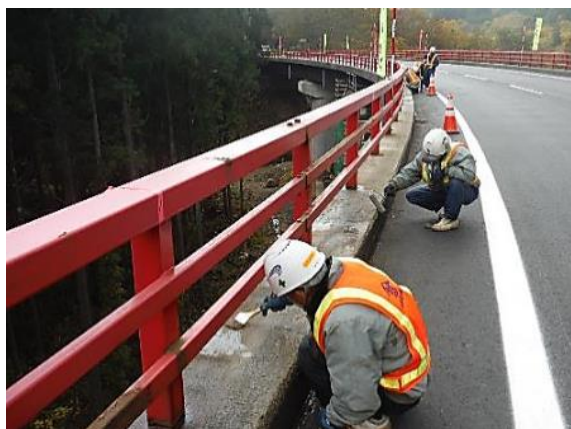
地覆：CS-21ビルダー塗布状況
