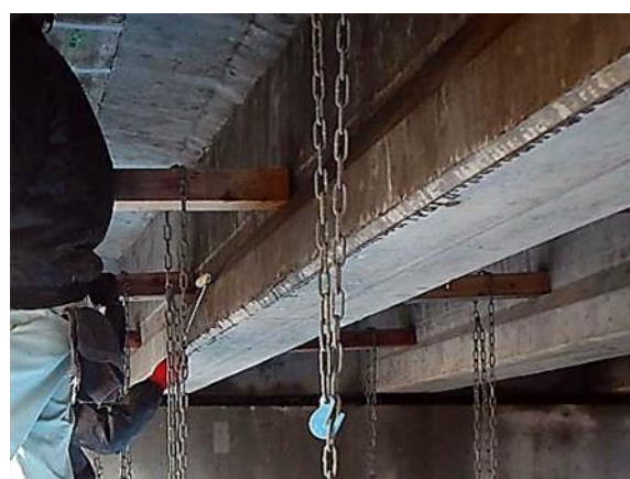
桁：CS-21ビルダー塗布状況
