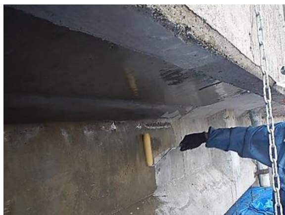
桁：CS-21ビルダー塗布状況
