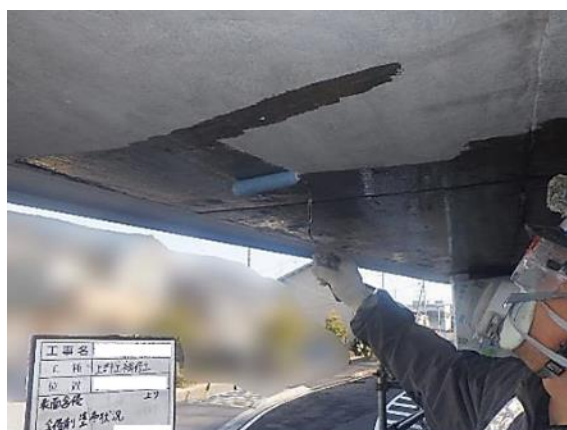
床版下面：CS-21ビルダー塗布状況
