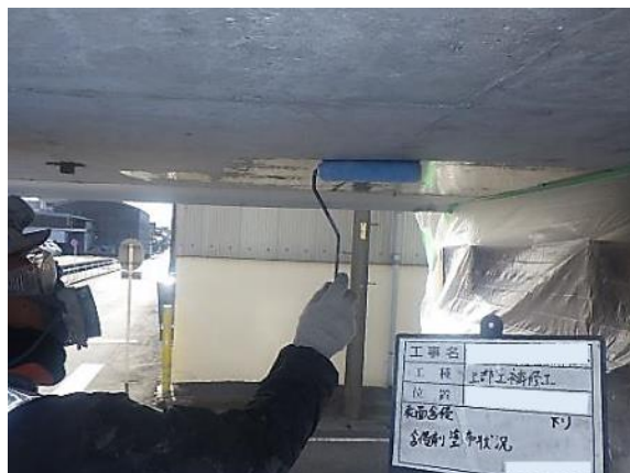
床版下面：CS-21ビルダー塗布状況
