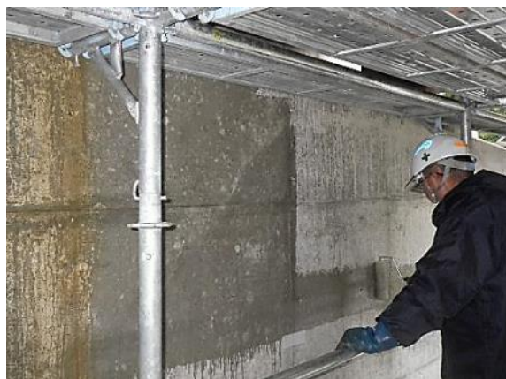
橋台：CS-21ビルダー塗布状況
