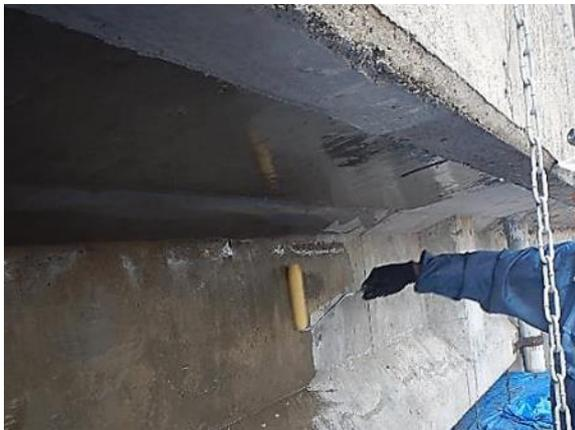
桁：CS-21ビルダー塗布状況
