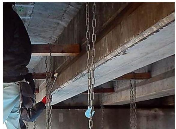
桁：CS-21ビルダー塗布状況
