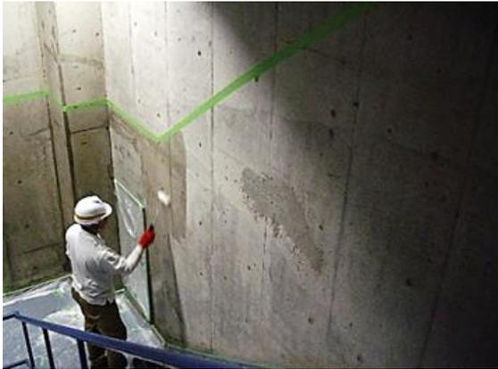
写真 15 CS-21 ビルダ―塗布状況
