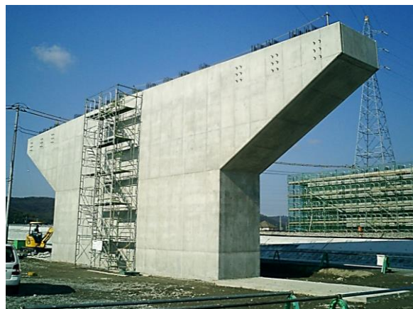
橋脚全景（施工完了後）
