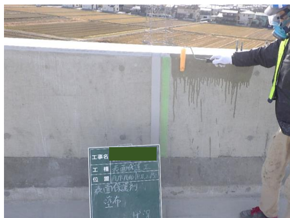
壁高欄：CS-21ネオ塗布状況
