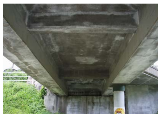
下面拡大：漏水・浮き共になし
