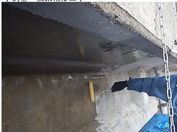
桁：CS-21ビルダー塗布状況
