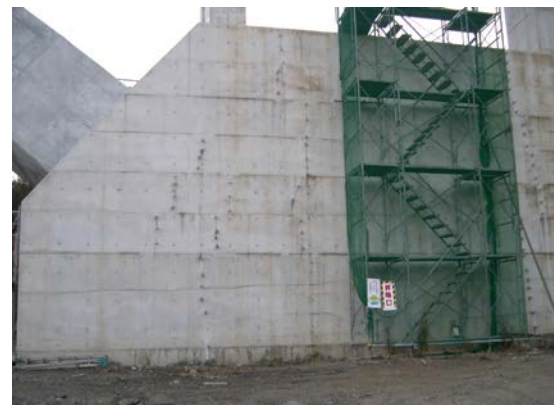
側面：微粒子セメント注入状況
