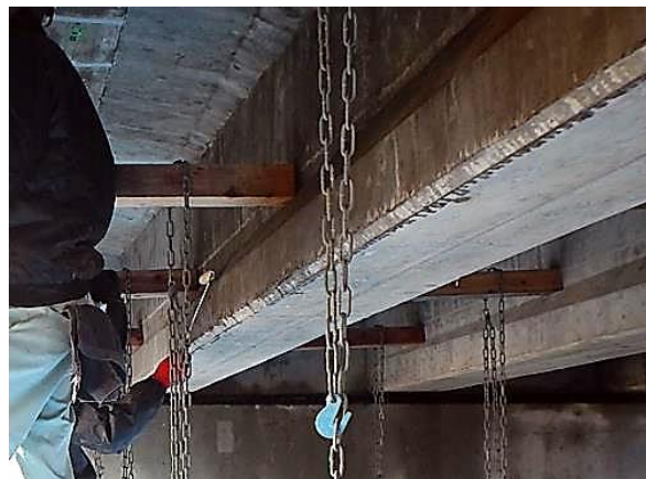
桁：CS-21ビルダー塗布状況
