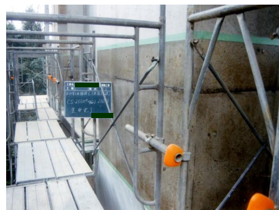
CS-21塗布（2回目）完了状況
