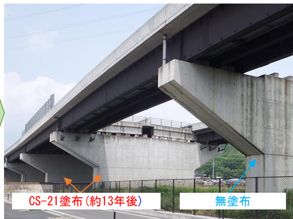
橋脚遠景・施工箇所全景（追跡調査時：施工から約13年経過時点）
