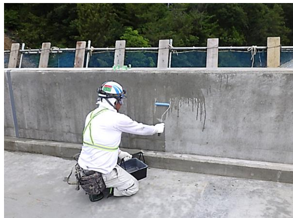
壁高欄：CS-21ネオ塗布状況
