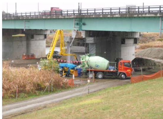
巻立てコンクリート打設状況
