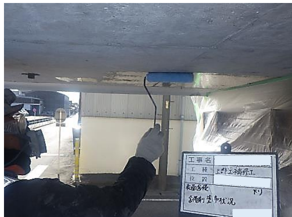
床版下面：CS-21ビルダー塗布状況
