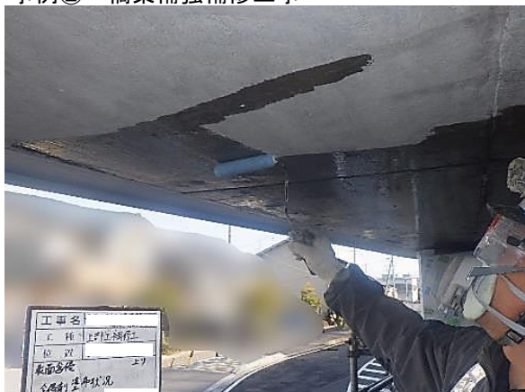
床版下面：CS-21ビルダー塗布状況
