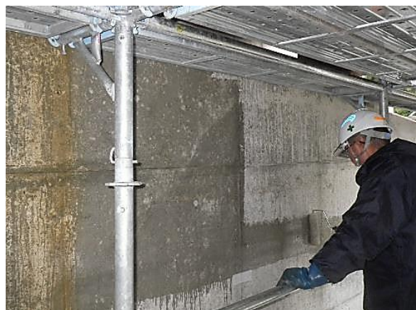
橋台：CS-21ビルダー塗布状況
