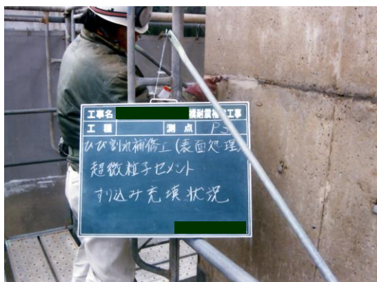
微粒子セメントすり込み状況
