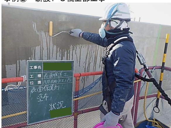
壁高欄：CS-21ネオ塗布状況
