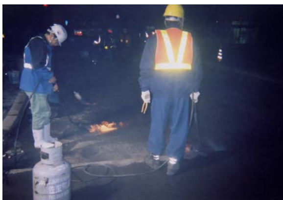
CS-21 施工前：強制乾燥
