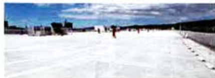
屋上駐車場防水
