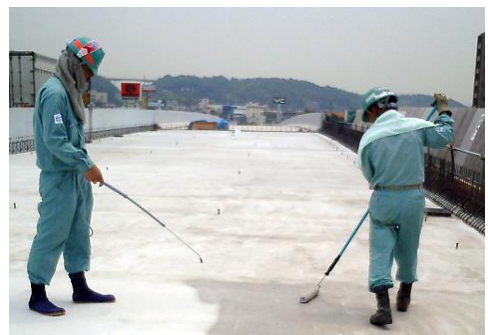
材料噴霧後、ローラー塗布状況
