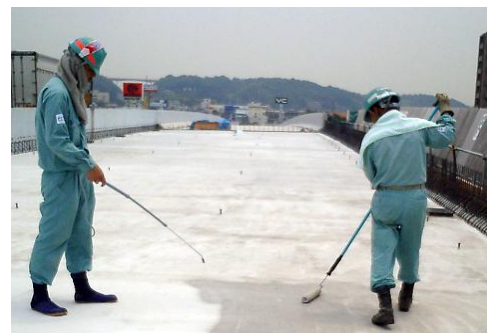
材料噴霧後、ローラー塗布状況
