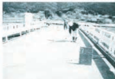
写真2 反応型けい酸塩系表面含浸材塗布
