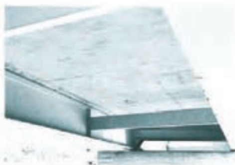
写真5 床版下面 (追跡調査時：施工から10年経過後)
