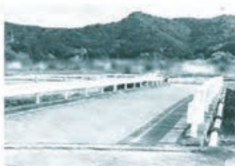
写真4 全景 (追跡調査時：施工から10年経過後)
