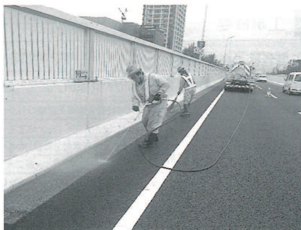
写真4 素地調整（高圧水洗浄）
