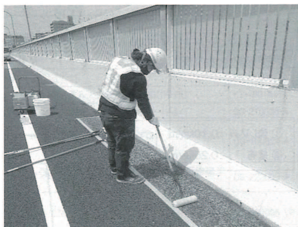
写真5 表面含浸材施工状況
