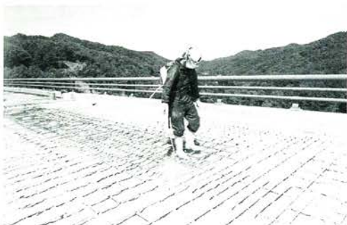
写真2 けい酸塩系表面含浸材散布
