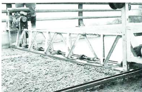
写真3 高精度打設機
