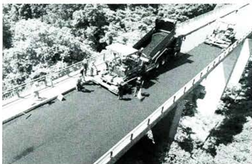
写真4 アスファルト舗装
