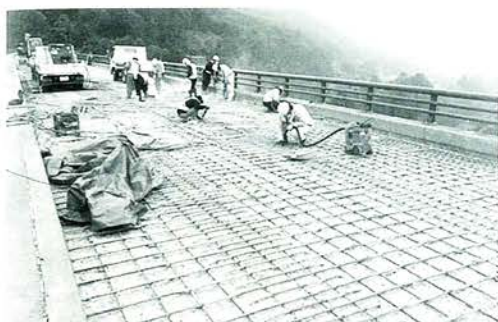
写真1 コンクリート劣化部除去
