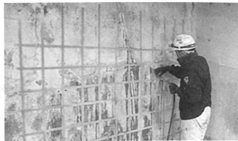
写真3 注入止水材 注入
