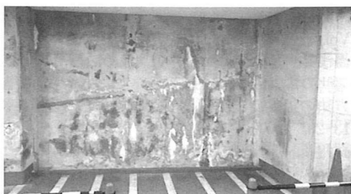
写真1 施工箇所全景
