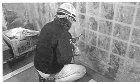
写真2 注入孔 削孔
