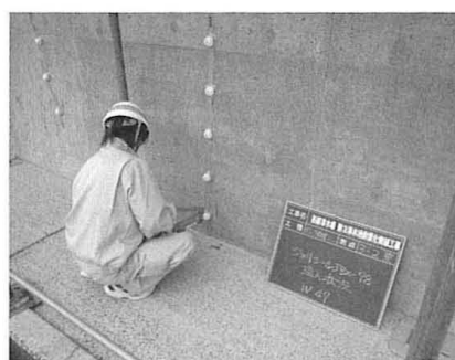
写真-2 ひび割れ注入(バルーン式)
