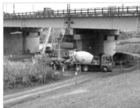
写真-1 巻立てコンクリート打設状況
