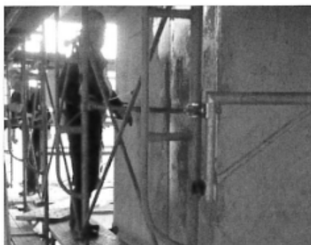
写真-2 材料散布状況
