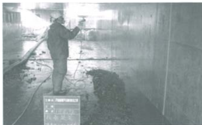
写真-2 浸透性コンクリート改質材散布状況
