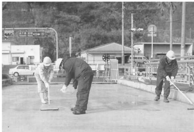
CS-21塗布状況
