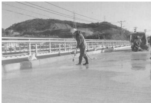
高圧洗浄状況
