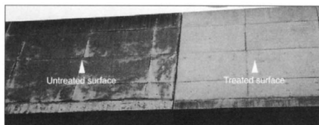
写真-1 浸透性吸水防止材による汚れ防止効果の状況 6)
