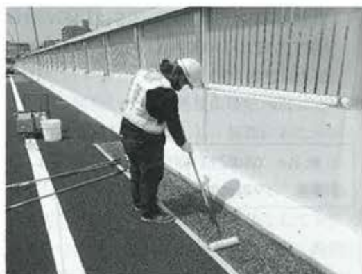
写真5 表面含浸材施工状況
