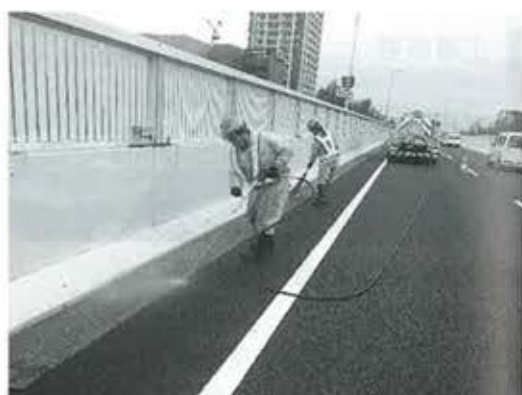
写真4 素地調整（高圧水洗浄）
