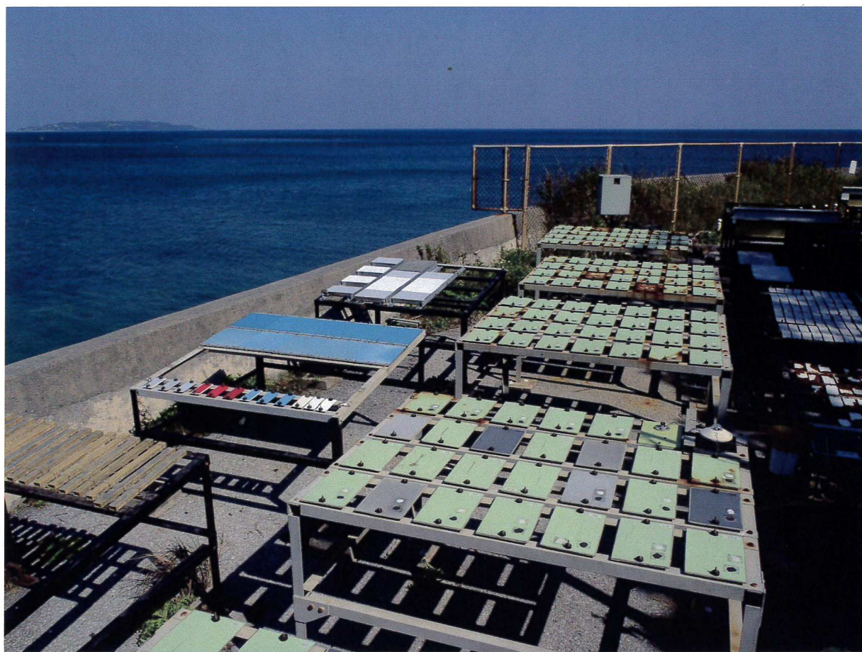
耐候性鋼材の塗装による補修効果の長期的検証状況
