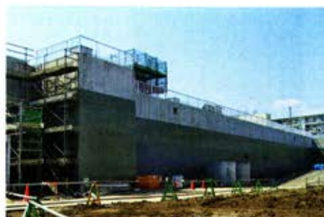
株アストン CS-21/CS-21 ネオ/CS-21 ビルダー Tel 086-255-1511 (5380 表面含浸工)
