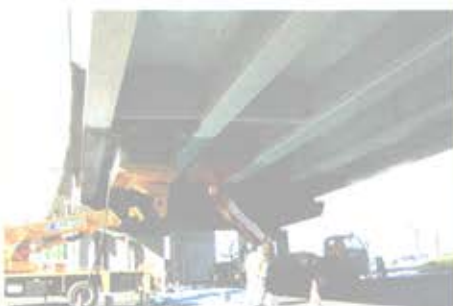
レジテクト工業会 レジテクト RT 工法 Tel 03-6434-7094 (5380 表面保護工)
