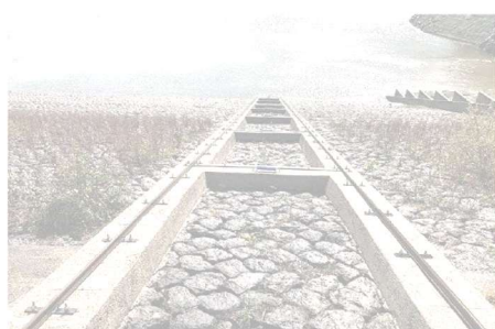
株インフラテックラボ グランシール R B タイプ (けい酸塩系表面含浸材) Tel 03-5288-6194 (538D 表面含浸工)
