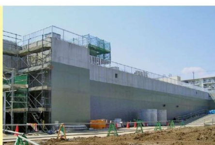
株アストン CS-21/CS-21ネオ/CS-21ビルダー Tel 086-255-1511 (538D 表面含浸工)
