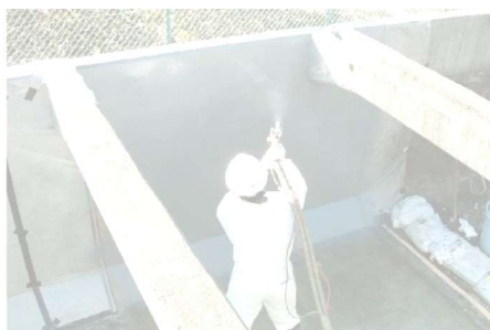
レジテクト工業会 C V スプレー工法 Tel 03-6434-7094 (538D 表面保護工)
