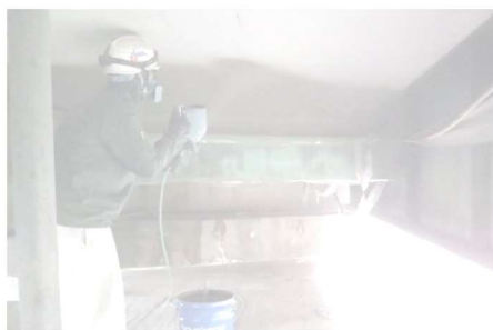
ザイベックス協会 ザイベックス工法 Tel 03-5786-6833 (538D 表面保護工)
