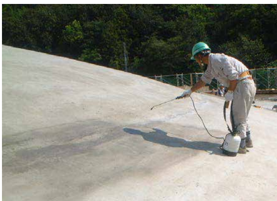
CS-21 散布状況
