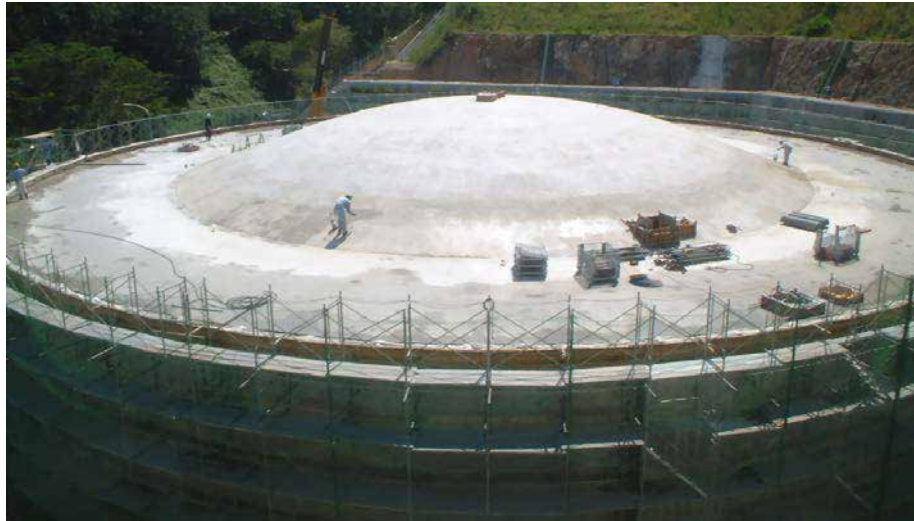
施工箇所 全景
