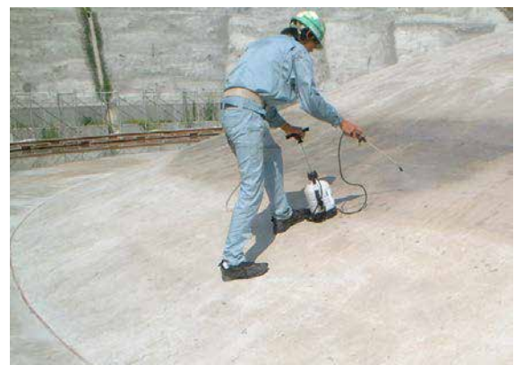
湿潤散水状況
