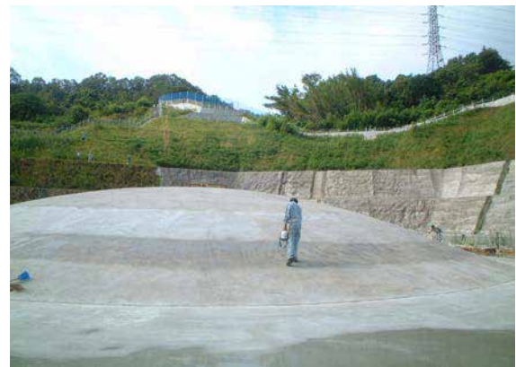
CS-21 散布状況
