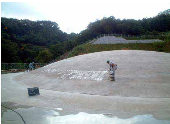
CS-21 散布状況
