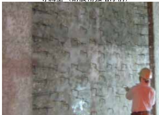
CS-21 散布状況
