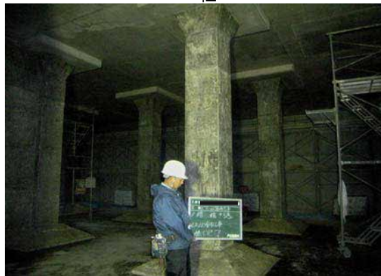
施工完了状況
