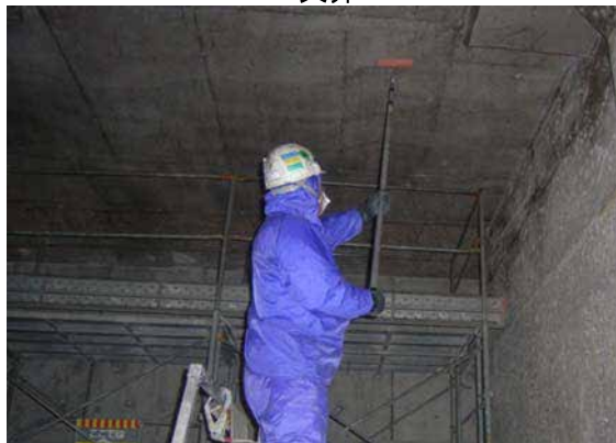
CS-21 塗布状況
