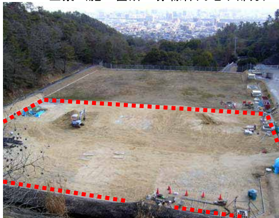
全景（施工箇所：赤線枠内地下部分）
