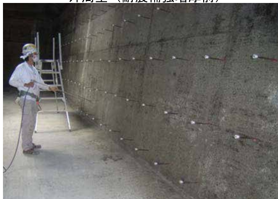
CS-21 散布状況
