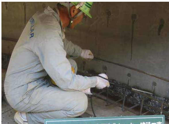
越流堰打継ぎ部：CS-21 散布状況
