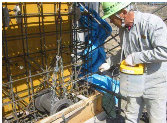
流出ピット配管部：CS-21 散布状況
