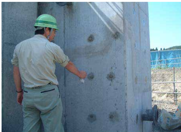
木コン処理：CS-21 散布状況
