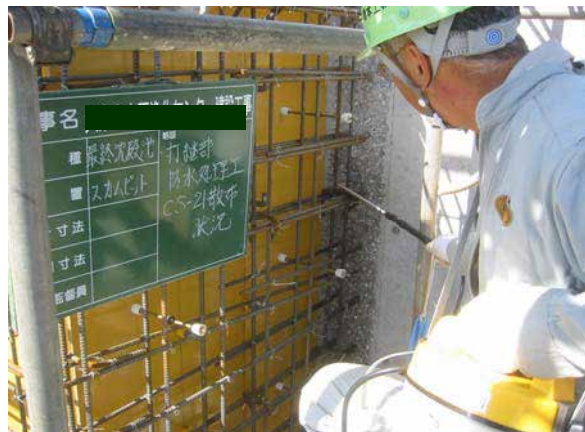
スカンプット打継ぎ部：CS-21 散布状況
