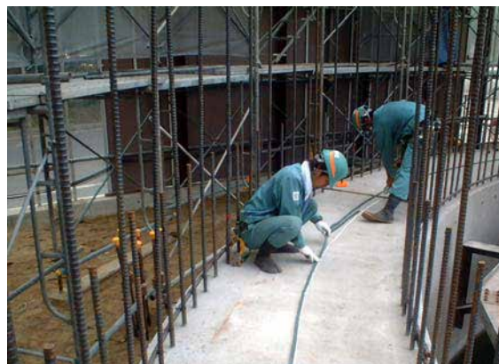
止水シール設置状況
