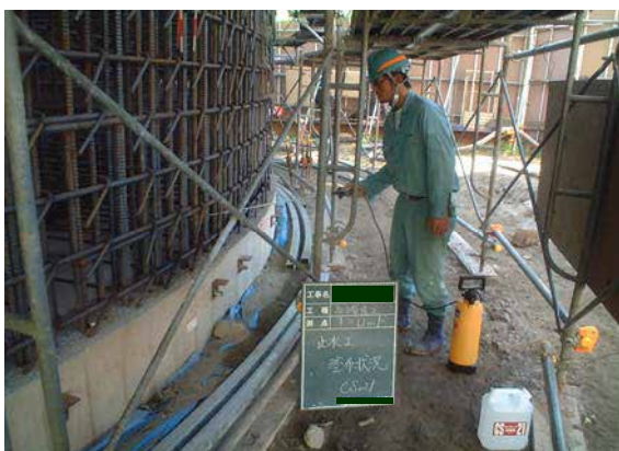
打継ぎ部：CS-21 散布状況
