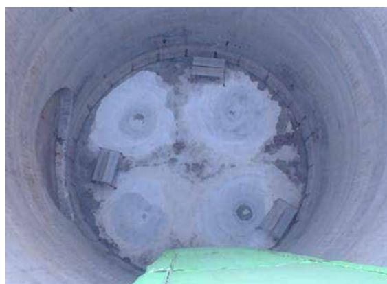
圧入後坑内状況
