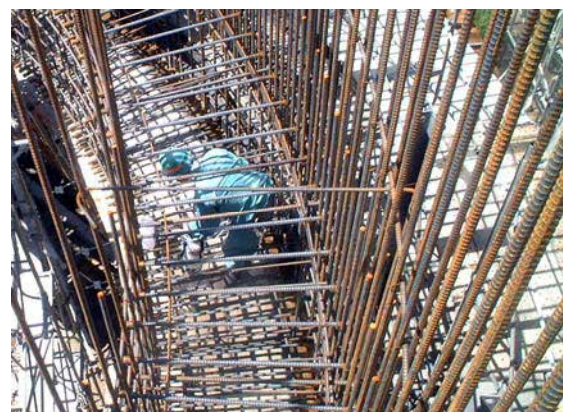
打継ぎ部：CS-21 散布状況
