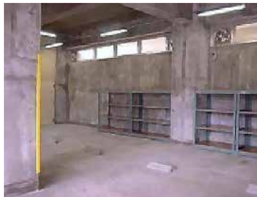
倉庫内床面：施工完了
