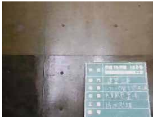
地下水槽外壁：施工完了
