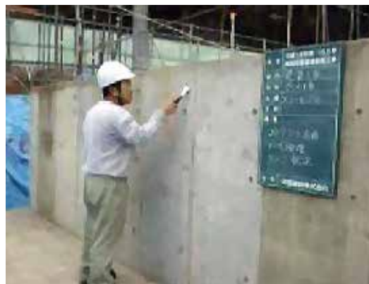
地下水槽外壁ケレン状況
