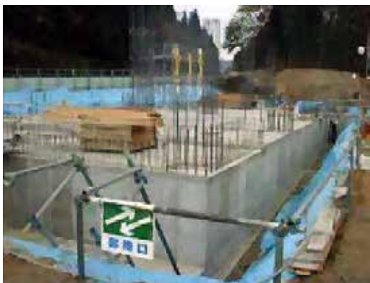
地下水槽全景
