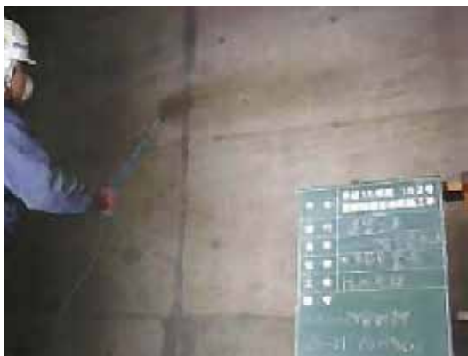
地下水槽外壁：CS-21散布状況
