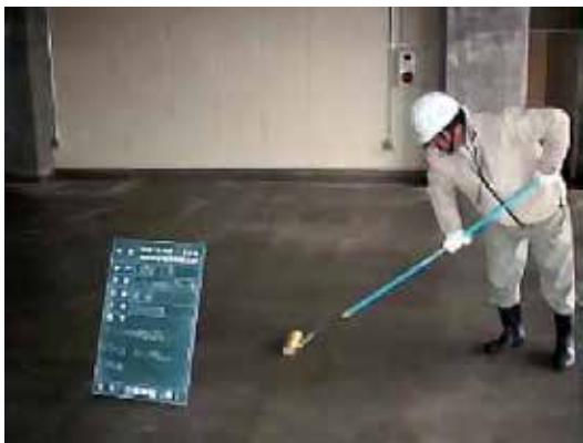
倉庫内床面：CS-21塗布状況
