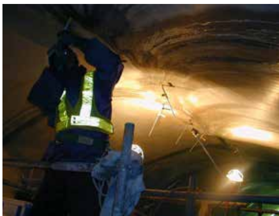
ひび割れ部：注入状況
