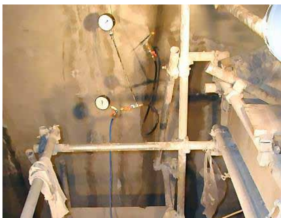
連続注入アタッチメントによる注入状況
