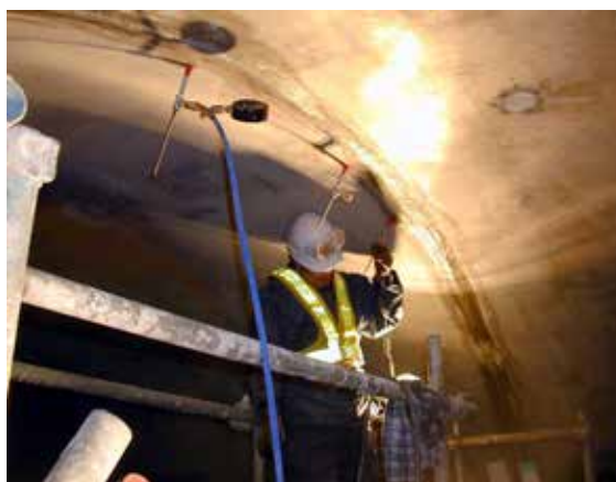
打継ぎ部：注入状況
