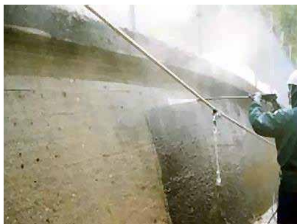
高圧洗浄状況
