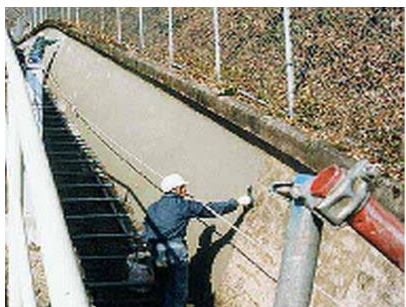
ポリマーセメントモルタル コテ塗り状況
