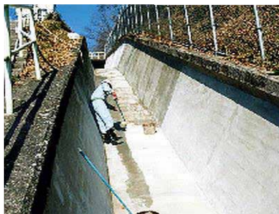
CS-21 塗布状況
