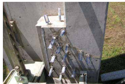
ひび割れ注入状況
