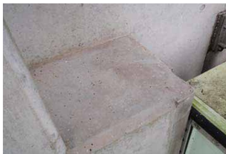
断面修復箇所
