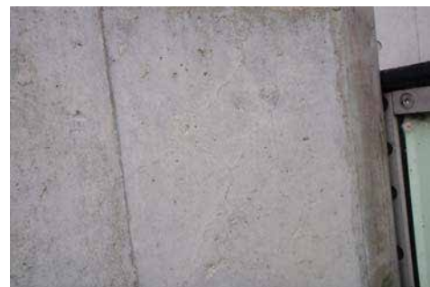
ひび割れ補修箇所
