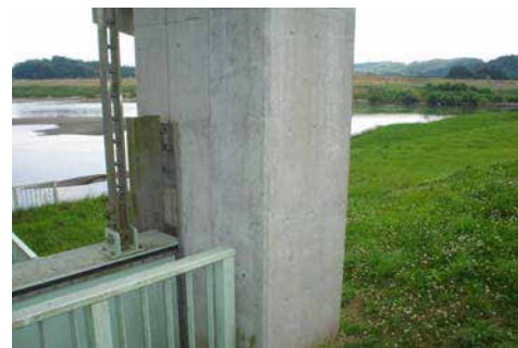
ひび割れ補修箇所
