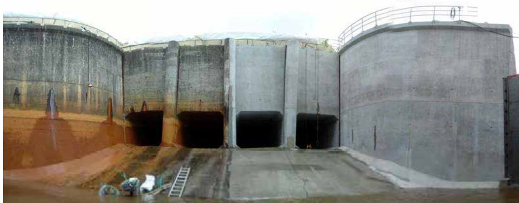
左側：施工前箇所 右：施工完了箇所
