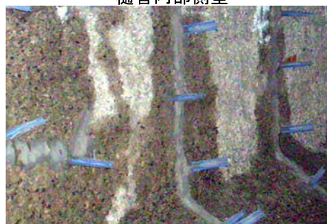
ひび割れ注入状況
