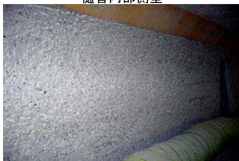
ハツリ工完了状況
