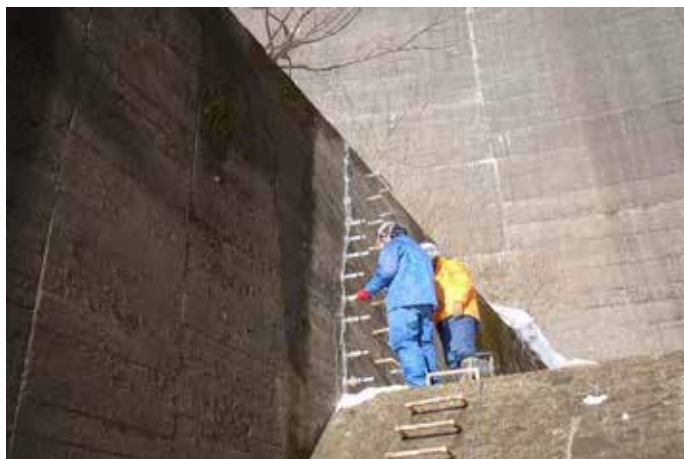
減勢工（ひび割れ低圧注入状況）
