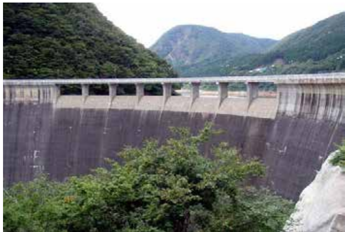
堤頂（上流側・下流側・高欄打継ぎ部）・越流部 施工完了
