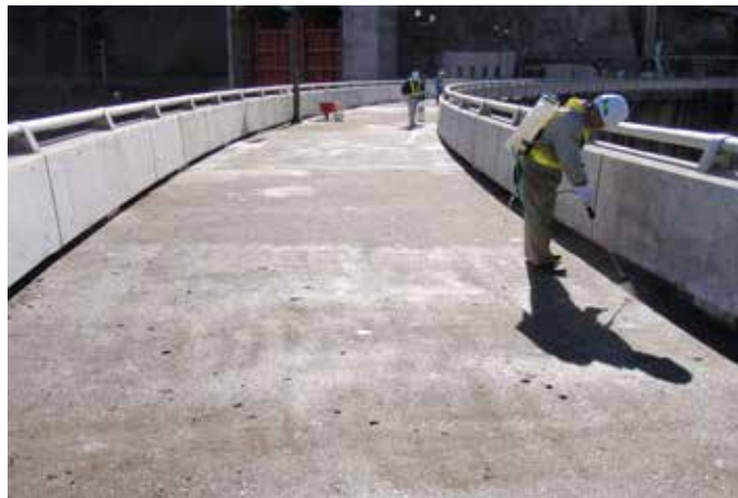
堤頂（CS-21 散布状況）
