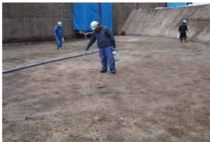
減勢工（CS-21 散布状況）
