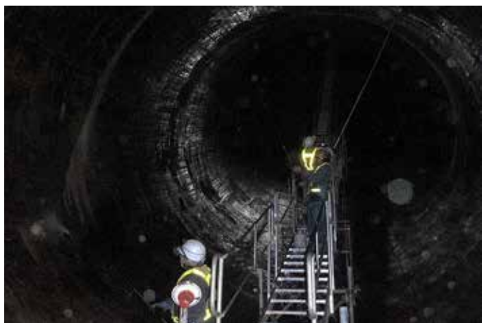
洪水吐トンネル（CS-21 散布状況）
