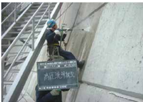
高圧洗浄状況
