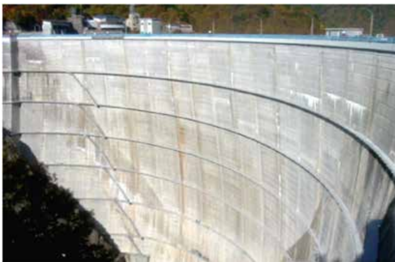
堤体下流面 全景
