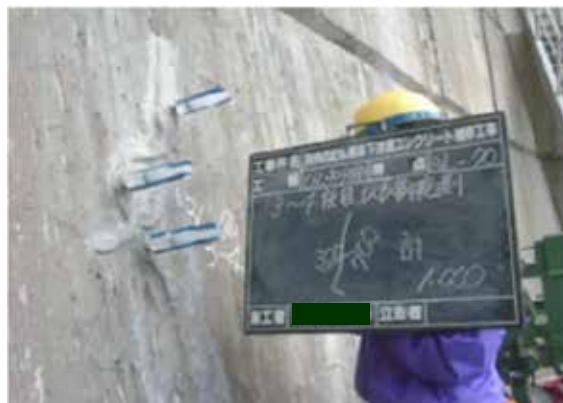
ひび割れ低圧注入状況
