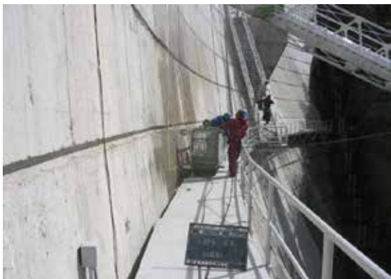
湿潤散水状況
