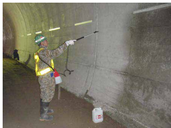
CS-21 散布状況
