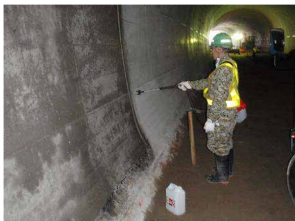
CS-21 散布状況
