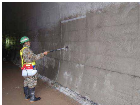
湿潤散水状況
