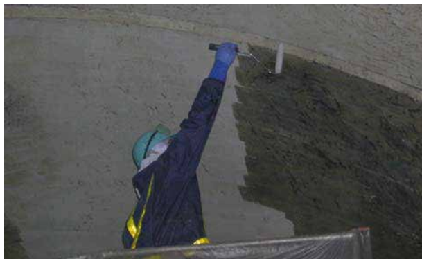
CS-21塗布状況
