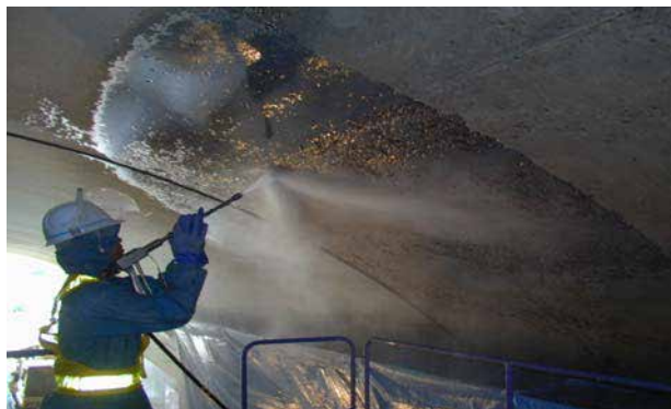
下地処理(高圧洗浄)状況
