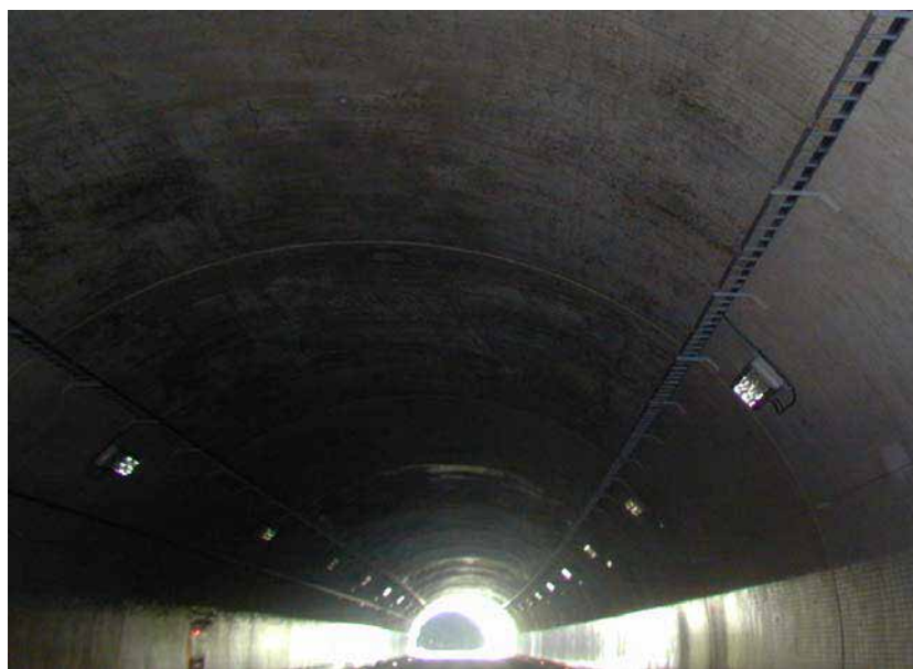
施工箇所全景
