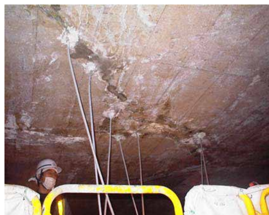
ひび割れ注入状況
