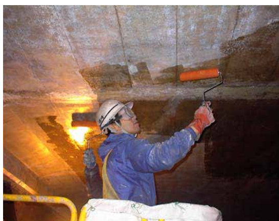
CS-21 塗布状況
