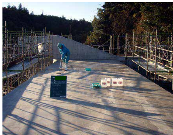
頂版：CS-21 塗布状況
