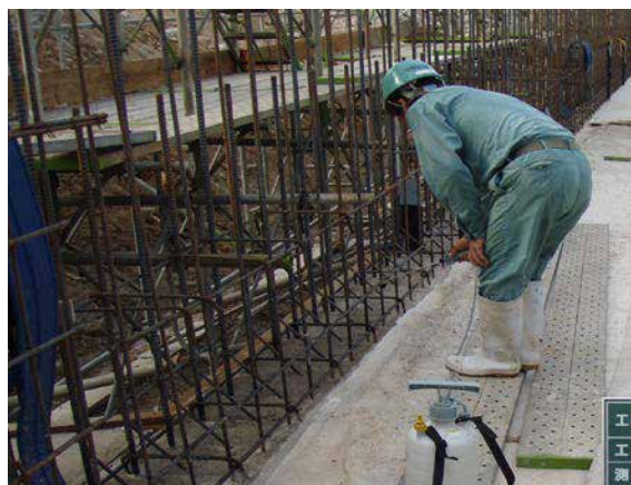
打継ぎ部：CS-21 散布状況
