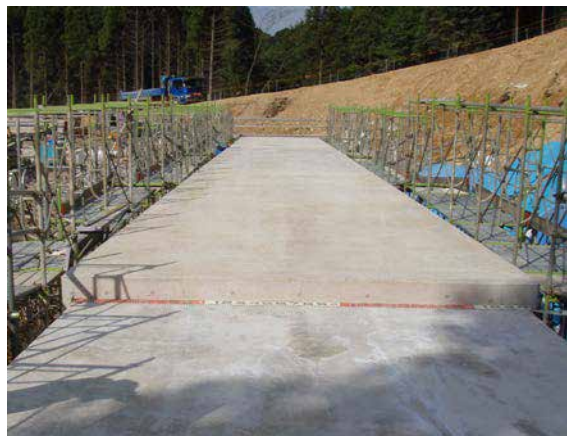
施工箇所全景
