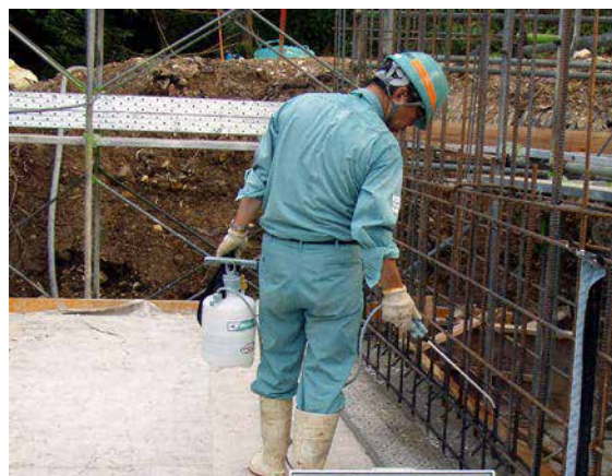
打継ぎ部：CS-21 散布状況
