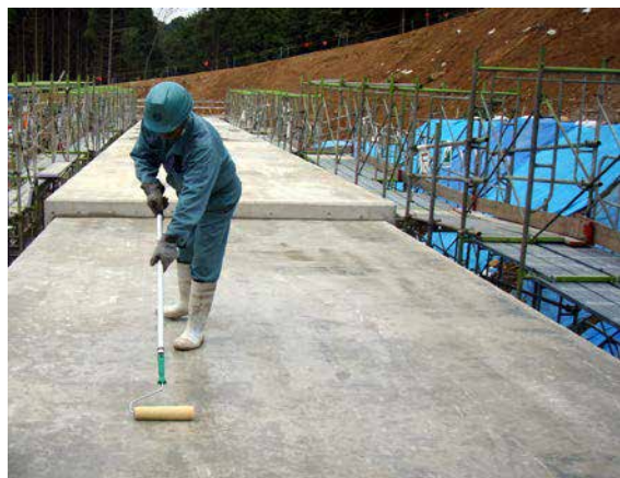
頂版：CS-21 塗布状況
