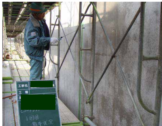
側壁：CS-21 散布状況
