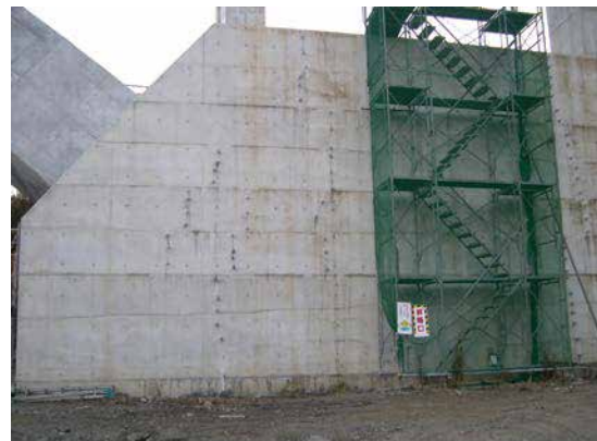
側面：微粒子セメント注入状況
