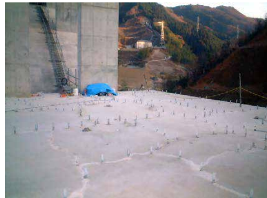
天端部：CS-21注入状況
