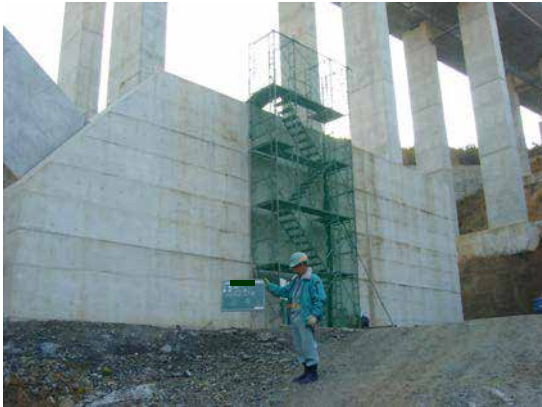
施工箇所全景
