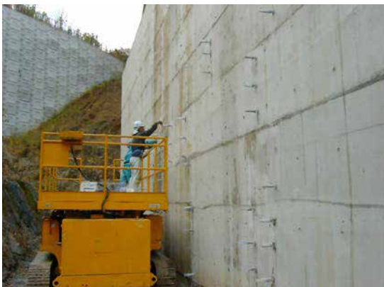
側面：CS-21注入状況
