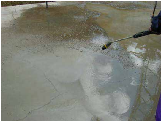
天端部：高圧洗浄状況
