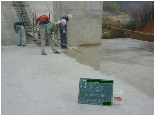
天端部：CS-21塗布状況
