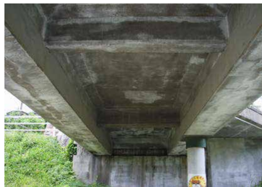
下面拡大：漏水・浮き共になし
