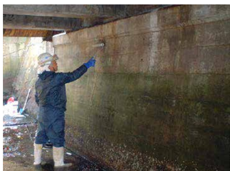
H橋 CS-21 塗布状況
