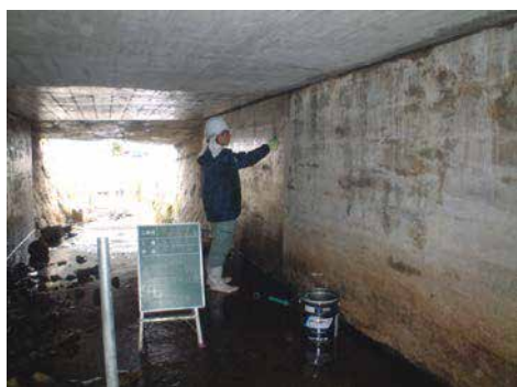
N橋 CS-21 塗布状況
