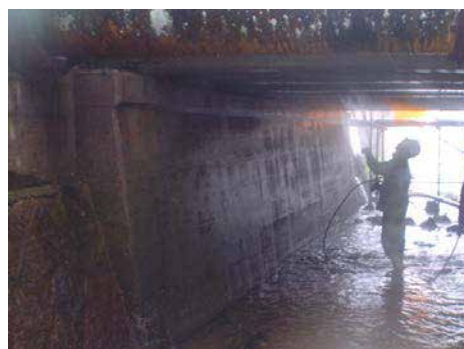
T1号橋 高圧洗浄状況
