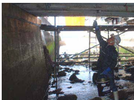
U橋 CS-21 塗布状況
