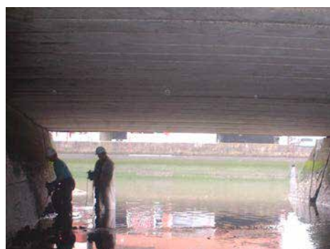
T3号橋 高圧洗浄状況
