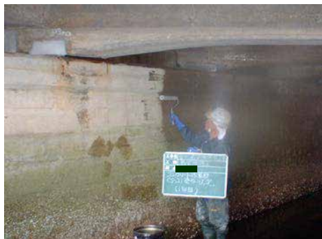
M橋 CS-21 塗布状況
