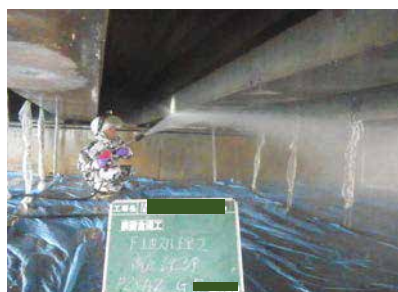
素地調整（高圧洗浄）
