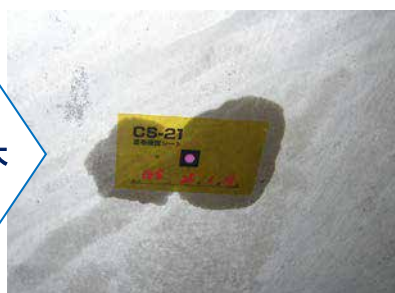
塗布確認シート（施工後）
