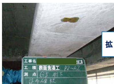
塗布確認シート（施工後）
