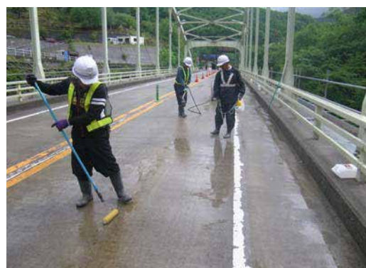
CS-21 塗布状況（床版上面）
