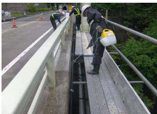
CS-21 塗布状況（地覆部）
