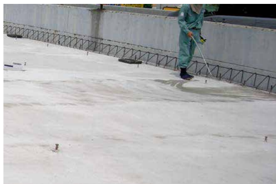
湿潤散水状況
