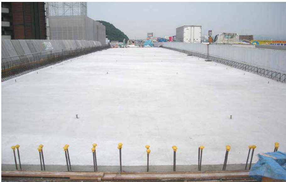
施工箇所全景
