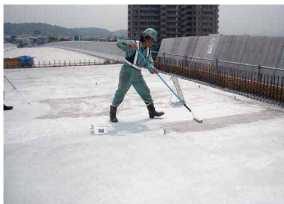
CS-21 塗布状況
