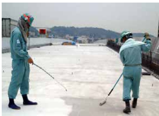
CS-21 塗布状況
