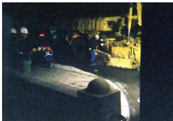
アスファルト切削状況
