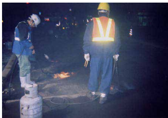
CS-21 施工前：強制乾燥
