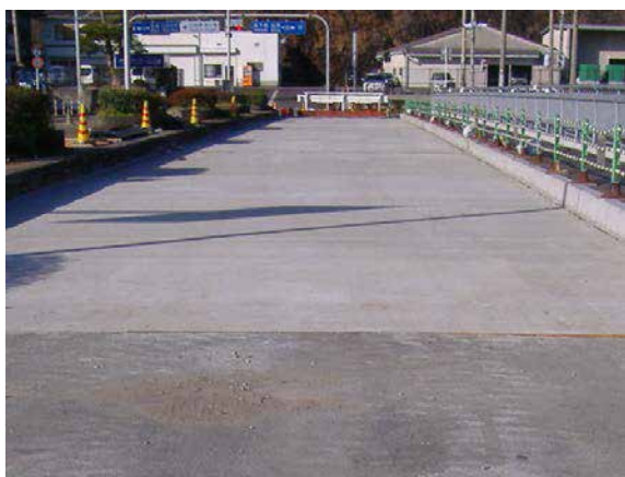
舗装撤去状況
