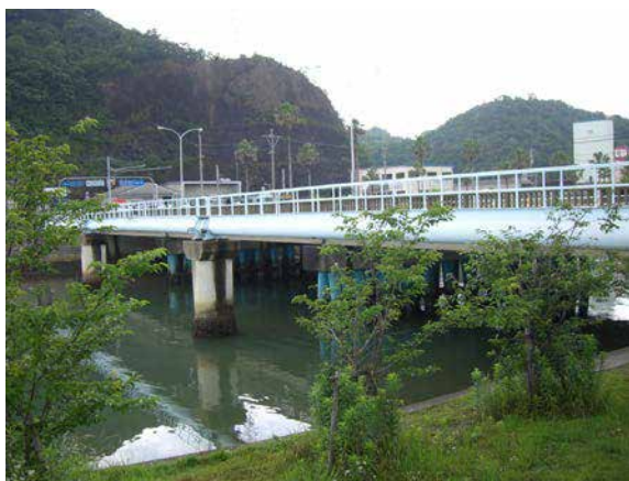
施工箇所全景
