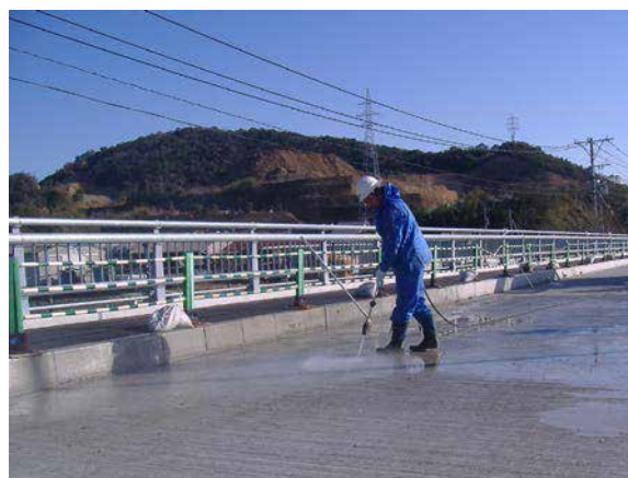
高圧洗浄状況
