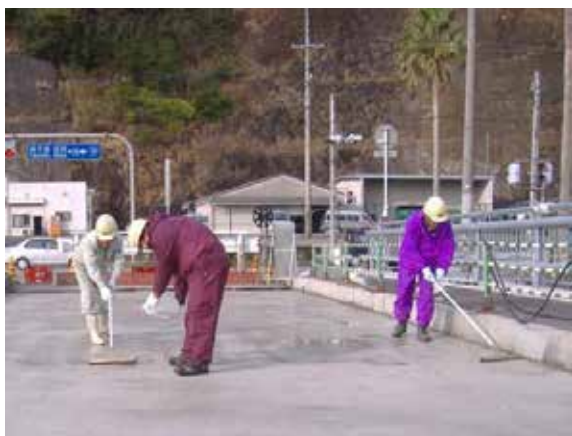
CS-21 塗布状況
