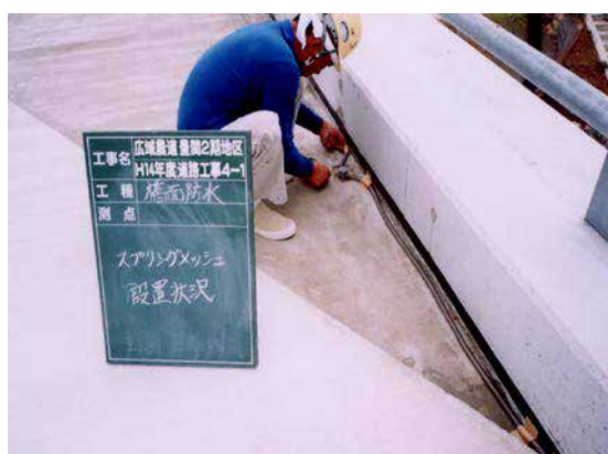
スプリングメッシュ設置状況
