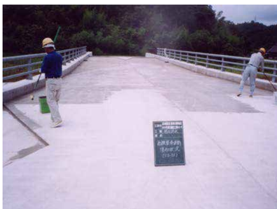
CS-21 塗布状況
