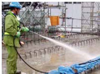
高圧洗浄状況
