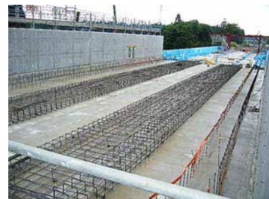
施工完了状況
