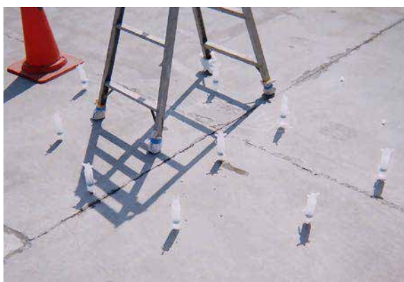
CS-21 低圧注入状況
