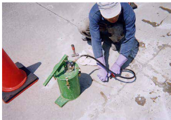
CS-21 注入状況 (ケミカルポンプ)
