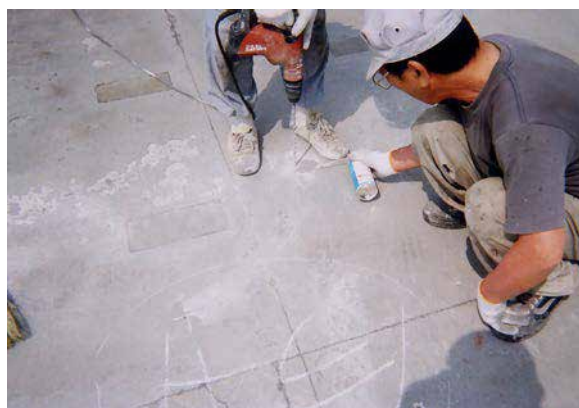
漏水箇所削孔状況
