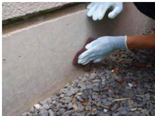
下地処理（清掃）状況
