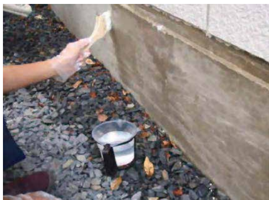
CS-21 塗布状況（外面）
