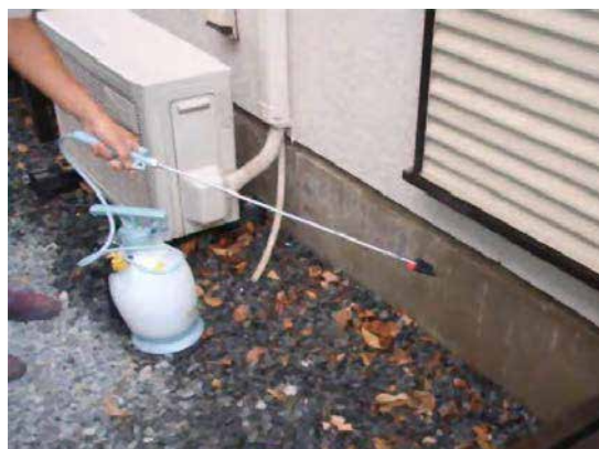
湿潤散水状況
