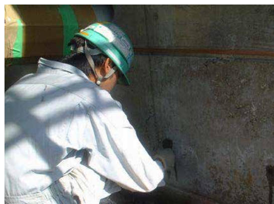
地下外壁：木コン部処理状況
