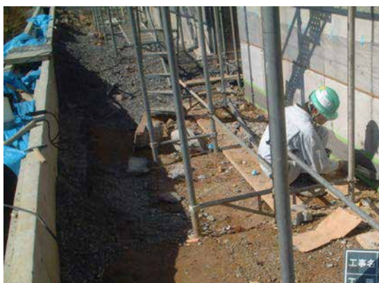
地下外壁：打継ぎ目処理状況
