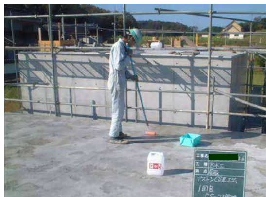
屋根：CS-21 塗布状況
