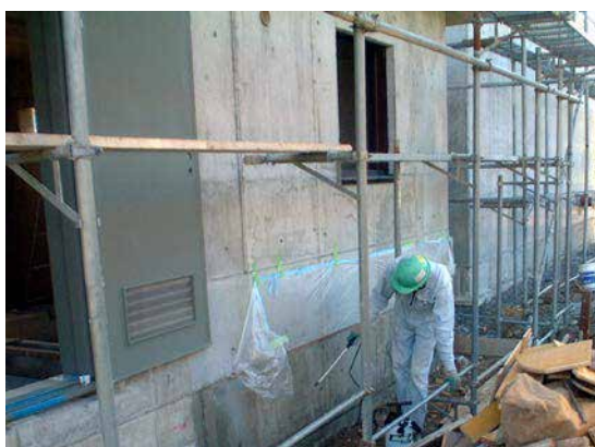
地下外壁：CS-21 散布状況
