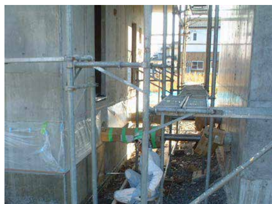
地下外壁：CS-21 散布状況
