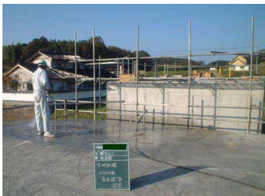
屋根：下地処理（高圧洗浄）状況
